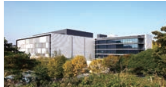
野村総合研究所データセンター
