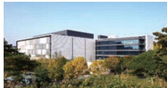
野村総合研究所データセンター
